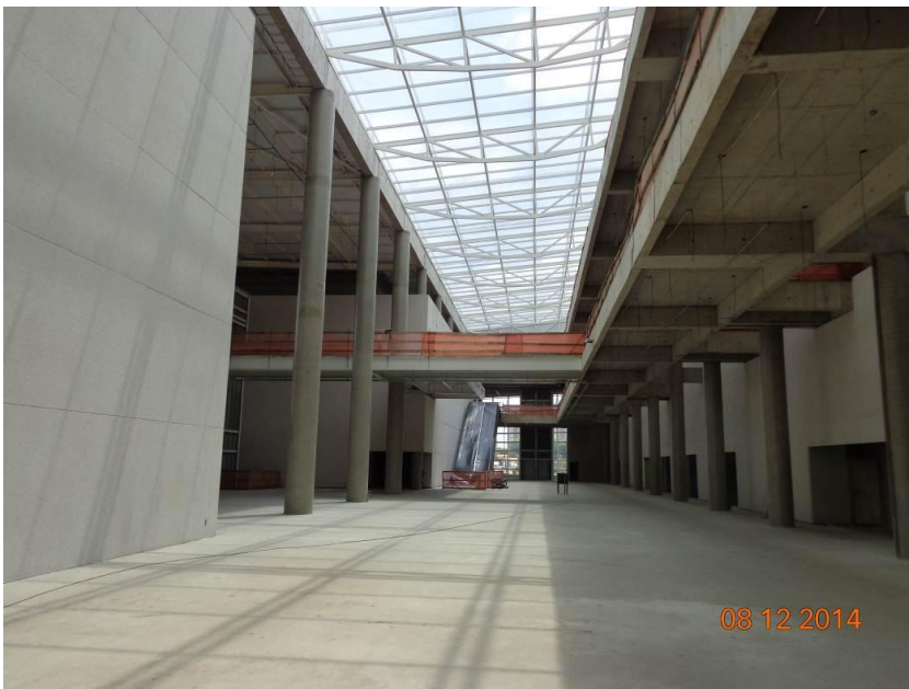
Imagem 11 – lanternim vista interna do saguão do térreo
