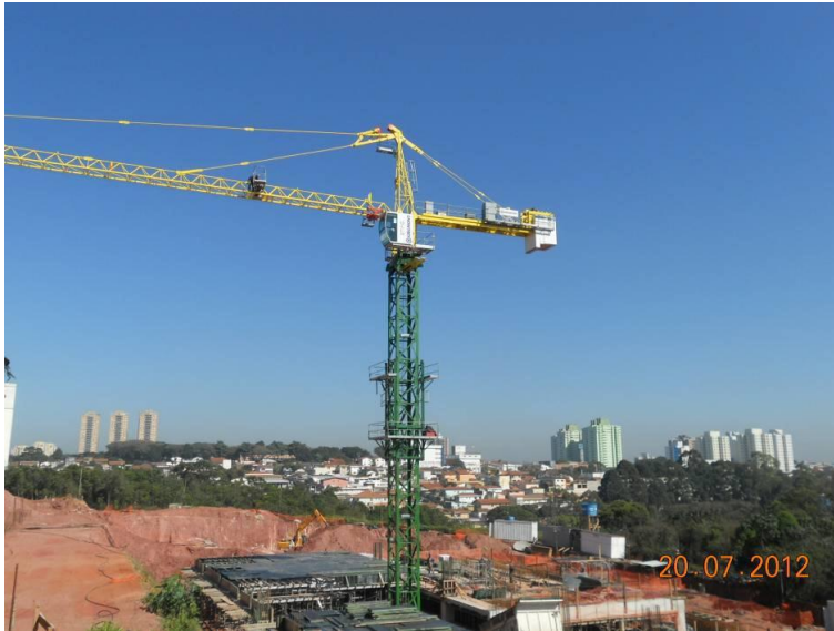
Imagem 01 - grua em operação no início das concretagens
