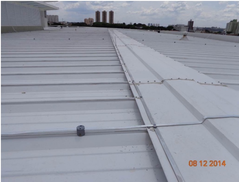
Imagem 25 – Cobertura e para-raios
