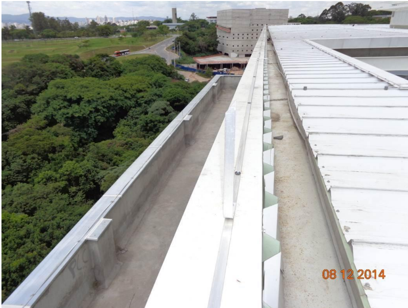
Imagem 24 – Cobertura e para-raios
