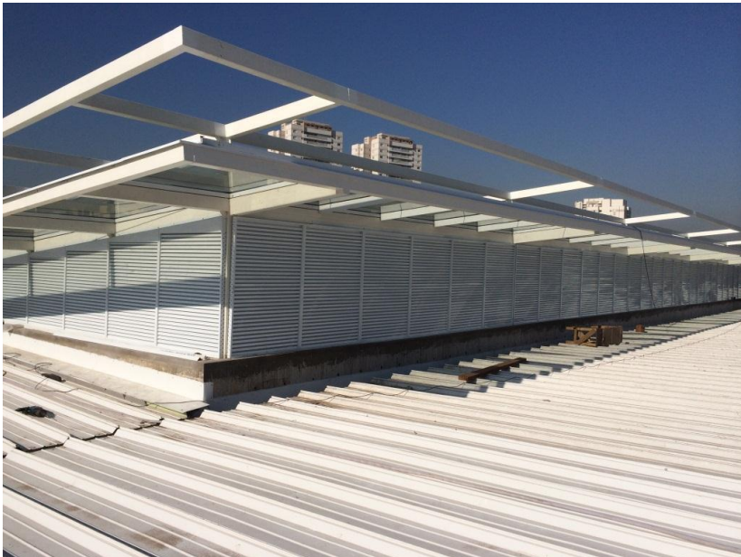
Imagem 09 – cobertura, ventilação e lanternim
