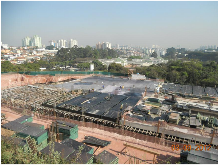
Imagem 03 – vista geral das primeiras concretagens
