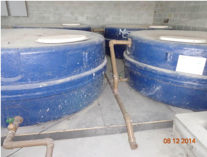
Imagem 21 – Caixas d'água superiores
