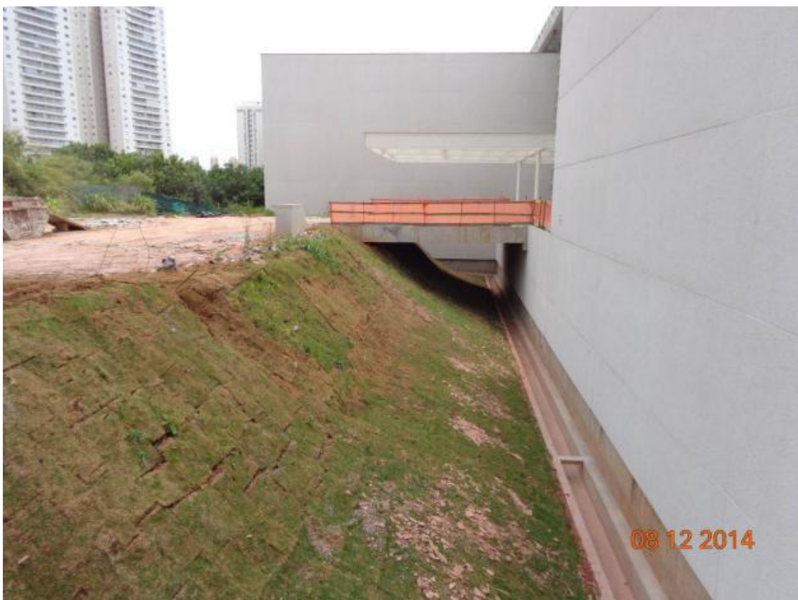
Imagem 06 – talude do eixo G reconstituído e gramado e canaleta de drenagem
