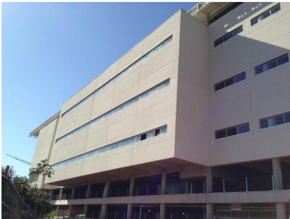
Imagem 04 – fachada eixo A
