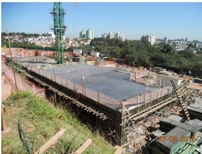
Imagem 02 – concretagem da laje do 2º subsolo
