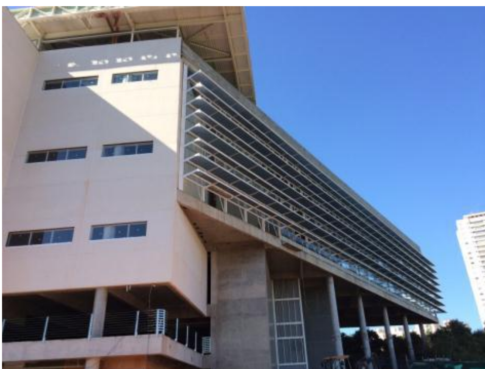
Imagem 07 – fachadas próximo ao eixo 1
